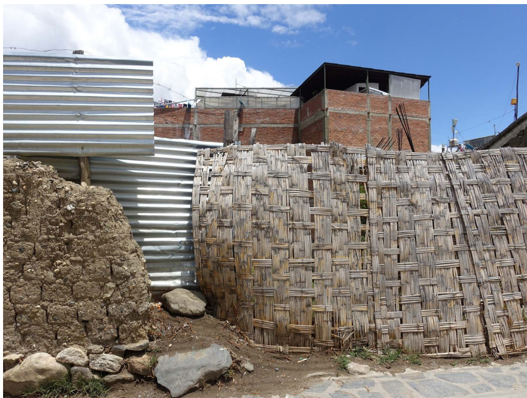
Il. 1. Esteras i calaminas , blacha falista i trzciniowe maty – najtańszy materiał budowlany. Fotografia autorki.
